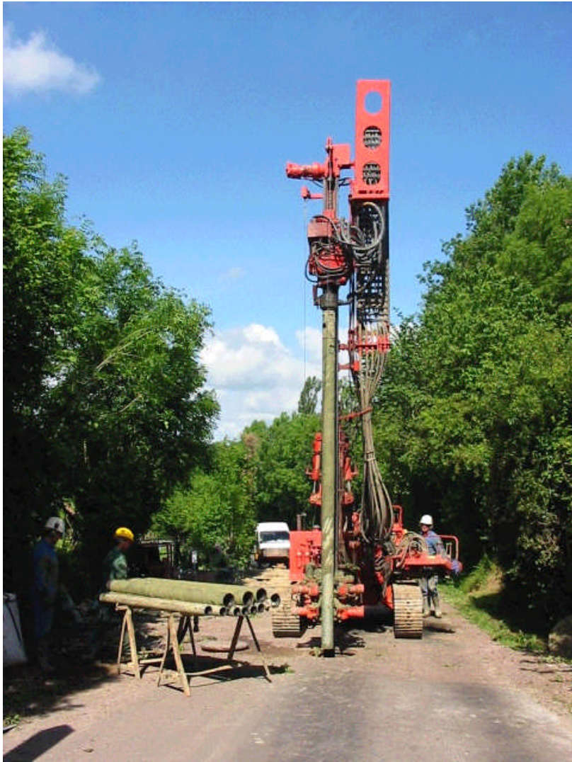
Mise en place sur regard
